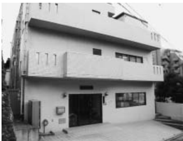
東京技術協会の本社ビル
